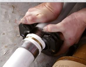
Greifen der Pressschlinge mittels Zwischenbacke
